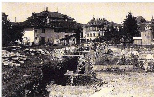
Offenbar waren auch früher Baustellen in der Stadt Wil an der Tagesordnung: Bau Poststrasse 1909.
