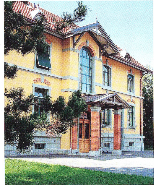
Das hundertjährige Stationshaus ist in ein zeitgemässes Patientenhaus umgebaut worden.
