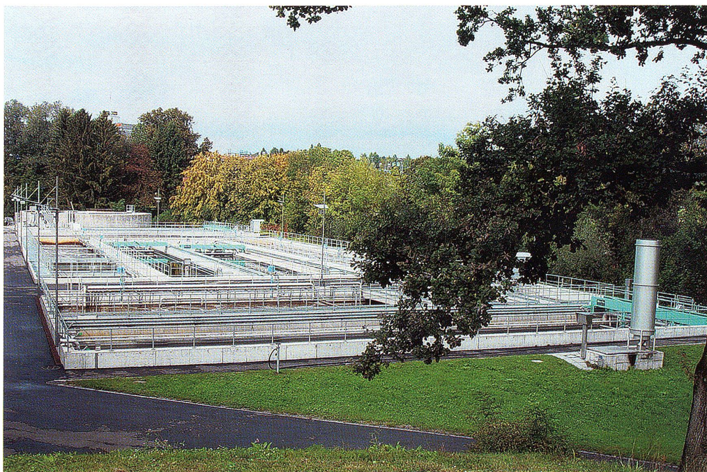
Die verschiedenen Reinigungsbecken auf einen Blick.
