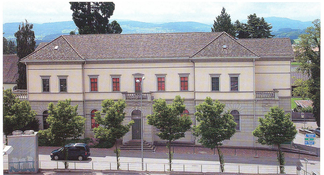
Die Tonhalle muss auch aussen saniert und Schäden an der Fassade behoben werden. Die Umgebung wird angepasst und die Aussenbeleuchtung verbessert.
