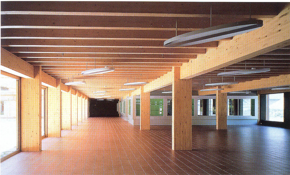
Konstruiert mit viel Holz.
