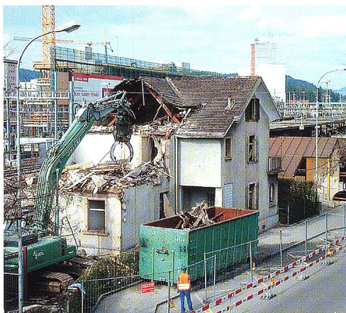
jes Das Bahnmeisterhaus wurde Ende April abgebrochen.
