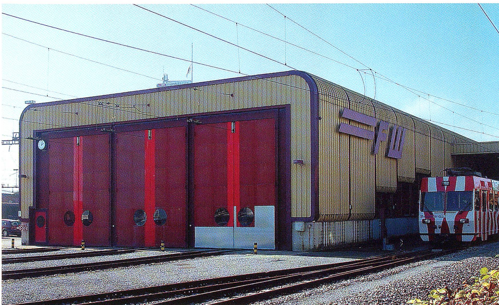
Das Betriebsgebäude der Frauenfeld-Wil-Bahn in Wil.
