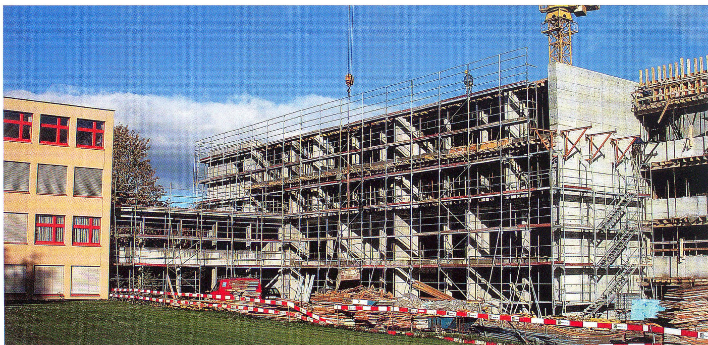
Der Baustand im Spätsommer 2003
