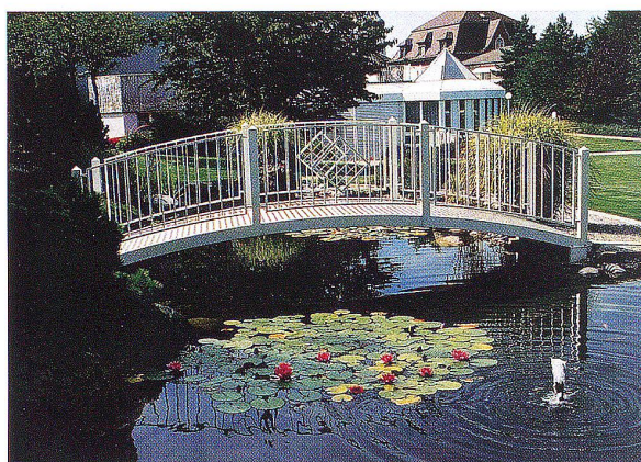
Brücke mit Geländer – gefertigt in unserer Schlosserei.
