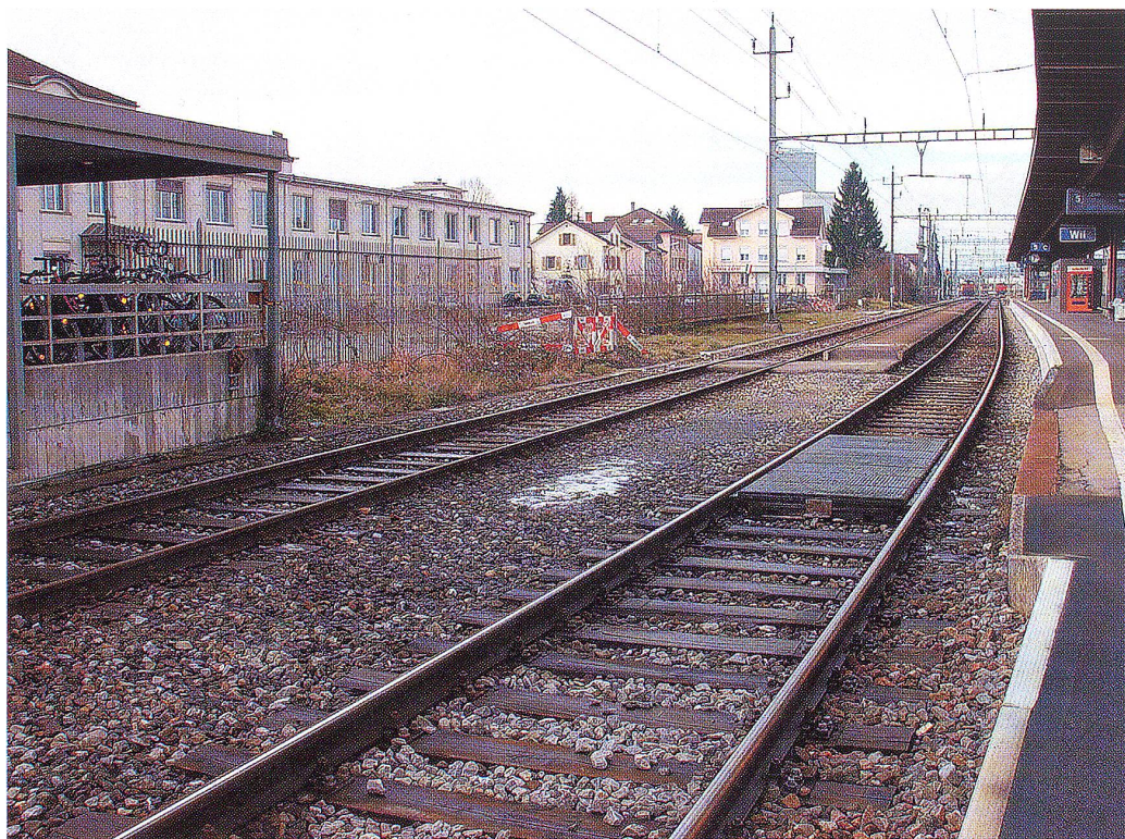
Hinter Gleis 6 entsteht der neue Bahnsteig für den integralen Halbstundentakt ab September 2005.
