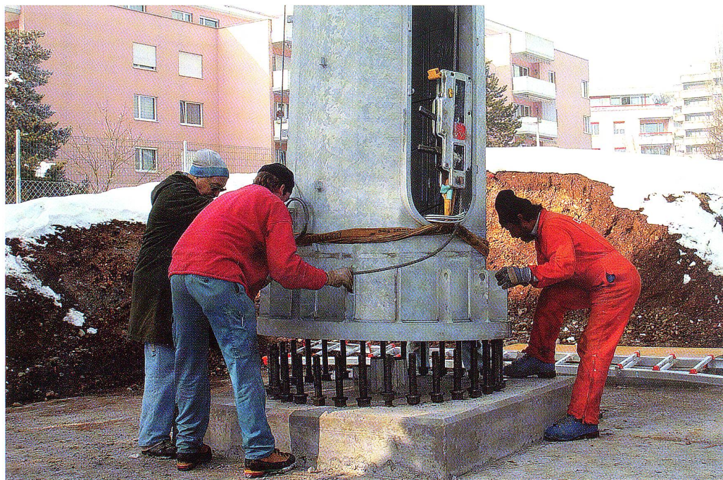
Es passt – der Mast wird auf das Fundament aufgesetzt.
