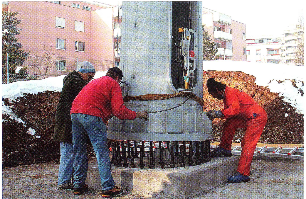
Es passt – der Mast wird auf das Fundament aufgesetzt.
