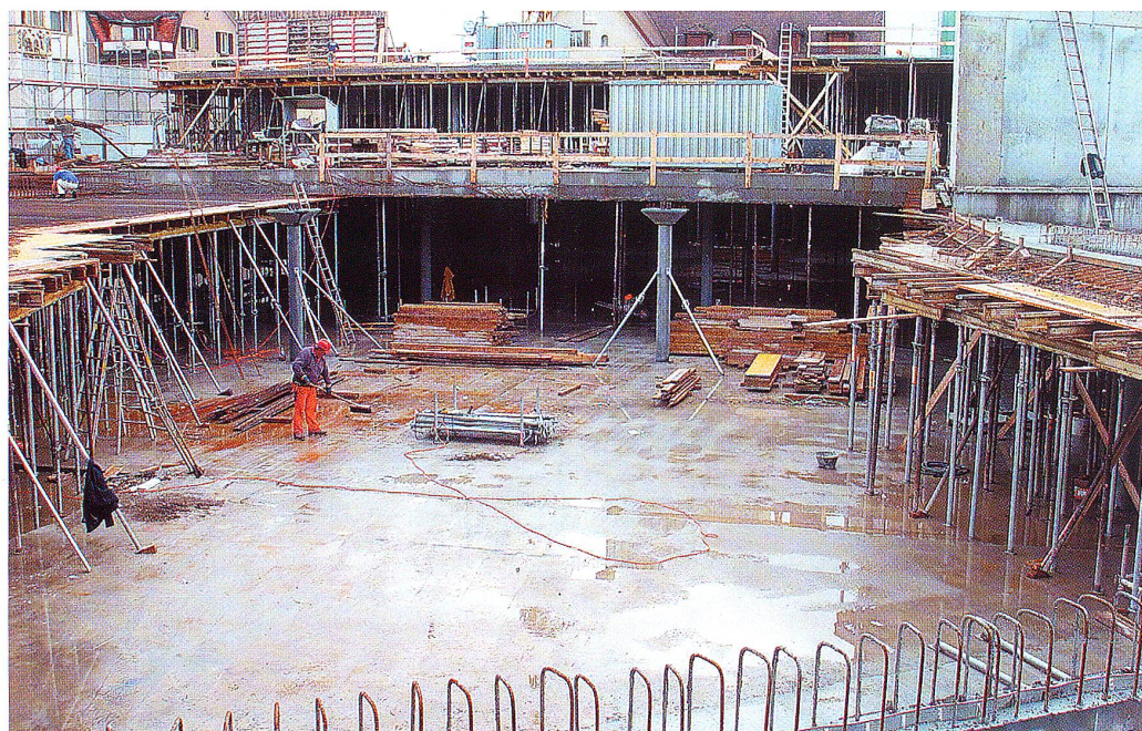
Die Bauarbeiten zum Bauvorhaben «Stadtmarkt» liegen vollständig im Zeitplan (Aufnahme anfangs Oktober).
