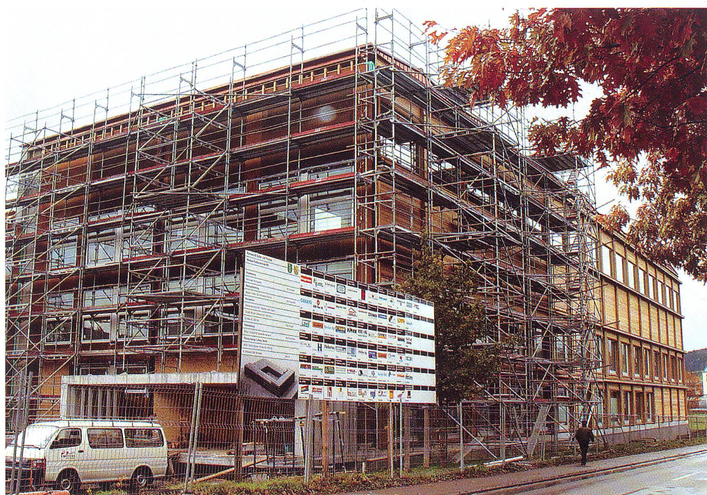
Die Wiler Kantonsschule nimmt Formen an.
