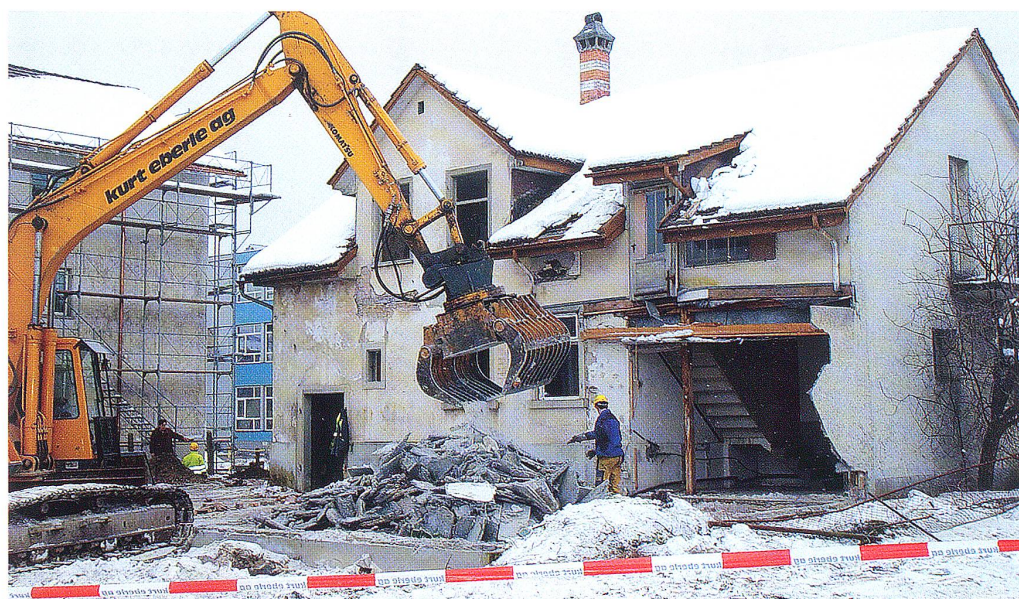
Der «Leuchtturm» an der Toggenburgerstrasse 103 in Wil wurde Mitte Februar abgebrochen.
