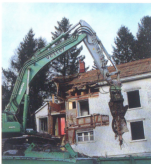
An der Hofbergstrasse 27 ist Mitte März der Abbruch-Bagger aufgefahren.
