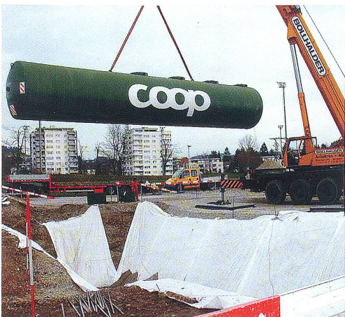
Am 11. März wurde der 22,7 Tonnen schwere Tank in die Grube versenkt. Er fasst 120 000 Liter Treibstoff.
