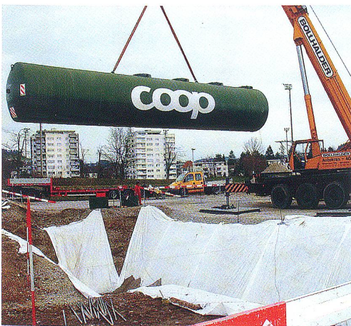
Am 11. März wurde der 22,7 Tonnen schwere Tank in die Grube versenkt. Er fasst 120 000 Liter Treibstoff.
