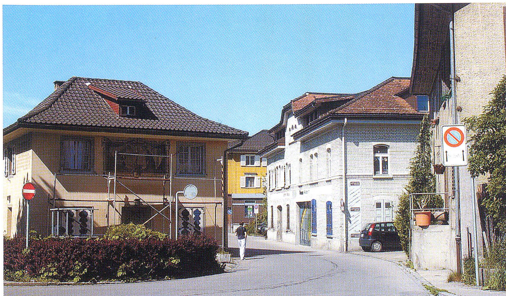
Die alte Klausenstrasse kurz vor der Bauphase für das neue Zentrum
