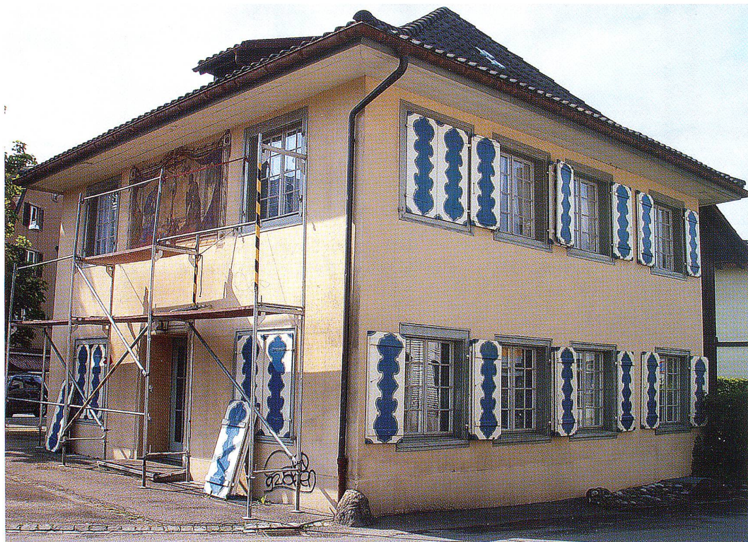
Das Bruder-Klausen-Haus kurz vor dem Abbruch
