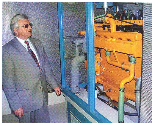
Stadtrat Werner Oertle erklärt den umgebauten Gas-Motor, der – von eigenem Biogas gespeisen – den Generator zur Stromerzeugung antreibt.
