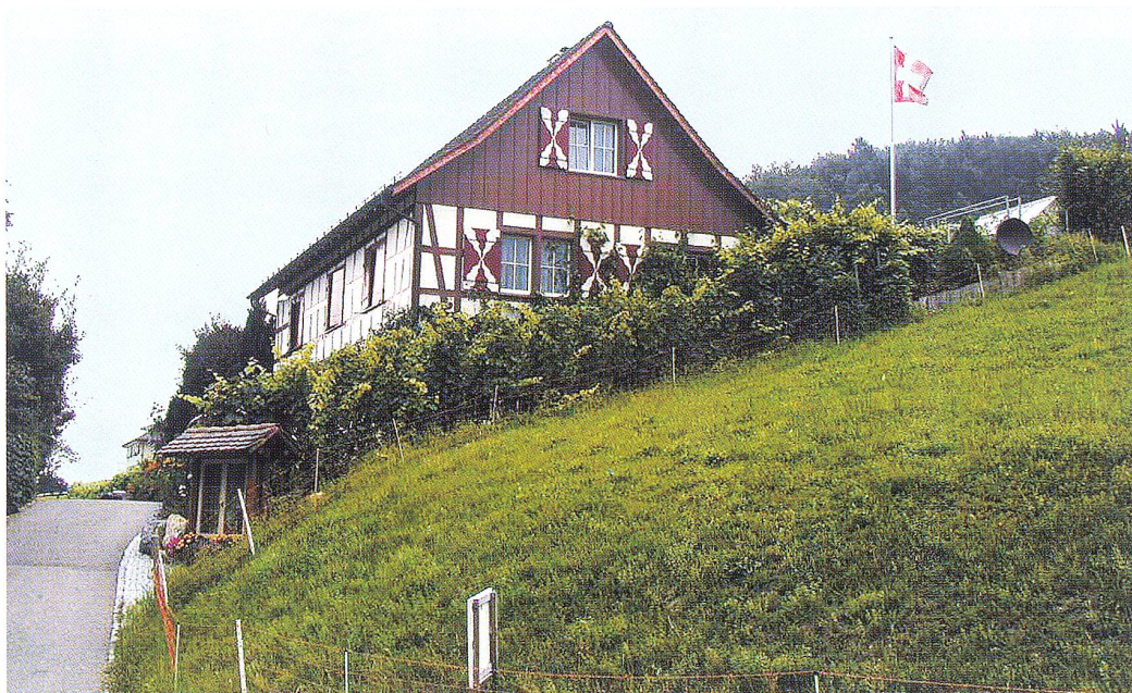
Renoviert und saniert: Bürgertrotte im Rebberg der Wiler Ortsbürger
