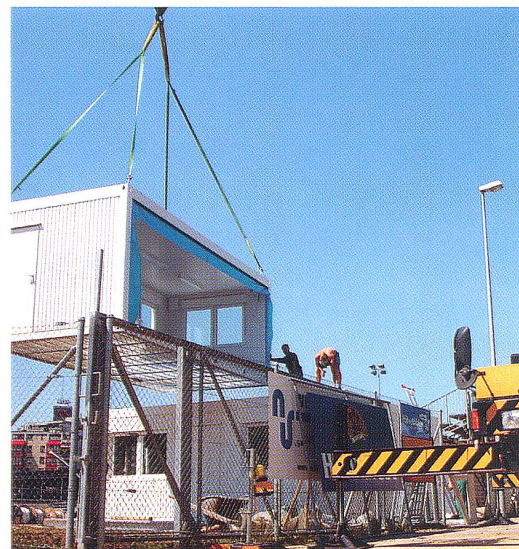
Montage der Büro-Container
