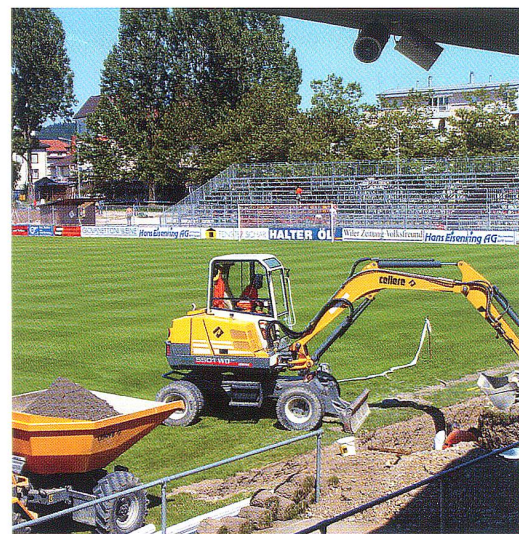
Baumaschinen auf dem Bergholz
