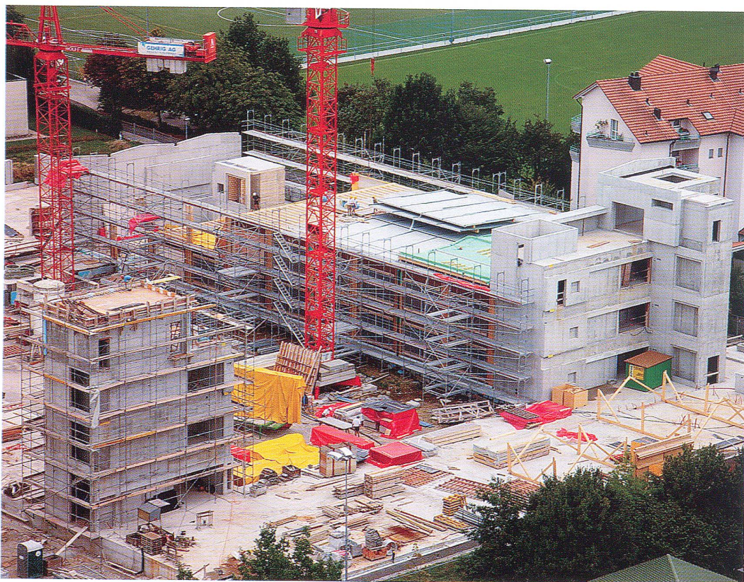
Blick vom Silo auf die Baustelle Kanti Wil: Die Aufrichtearbeiten haben begonnen (Stand Ende August).
