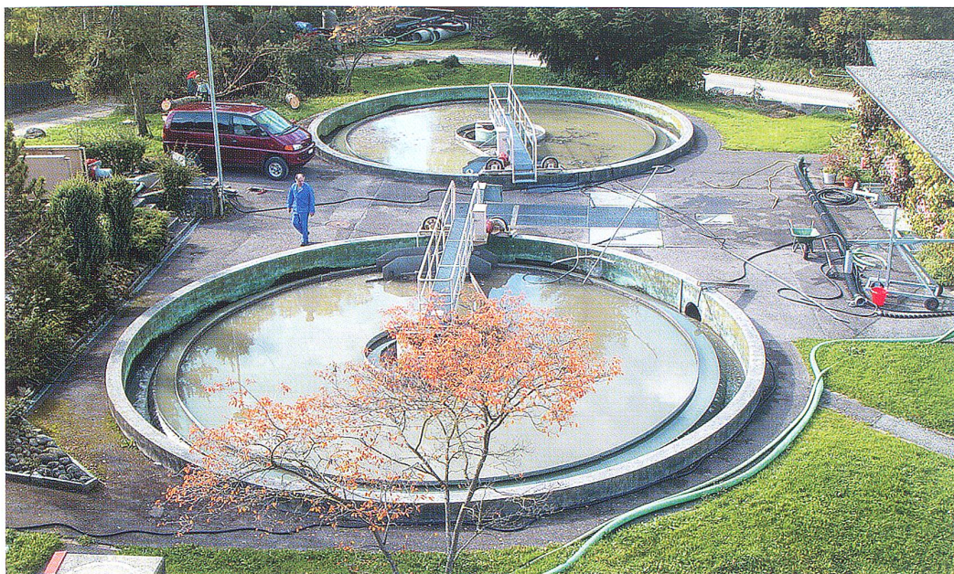
Die alten Vorklärbecken werden für das Phostrip-Verfahren umgebaut.
