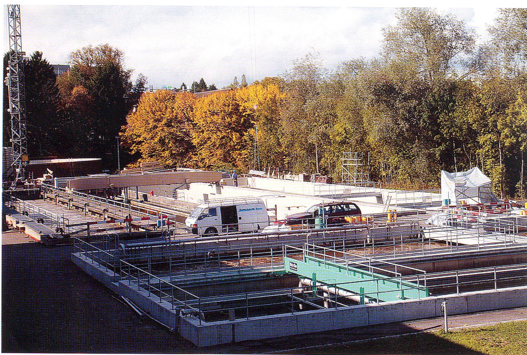
Die neuen Vorklärbecken (Bildmitte, rechts) können demnächst in Betrieb genommen werden.
