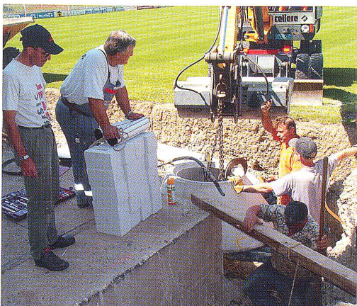
Umfangreiche Arbeiten, um neue Kabel und Installationen zu verlegen
