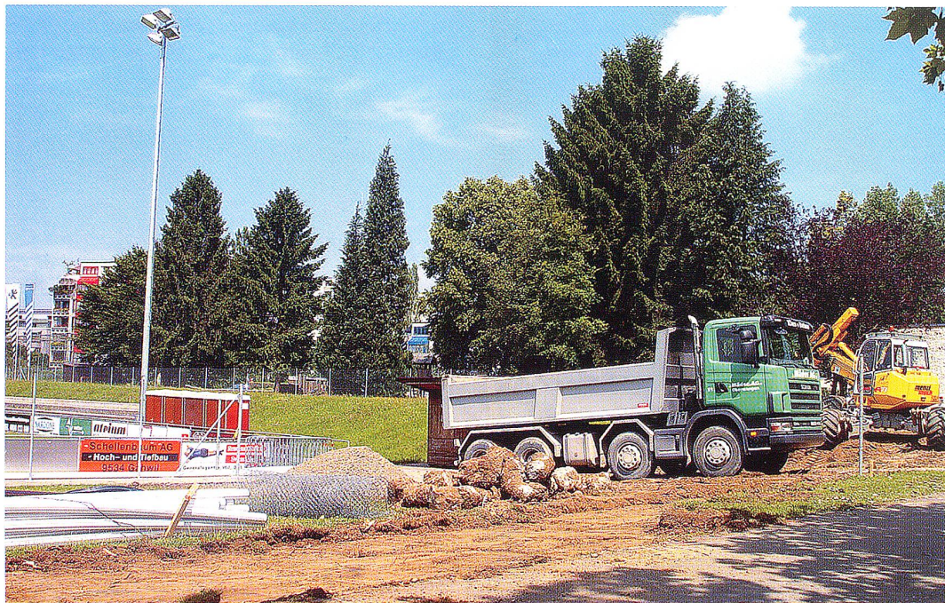
Die Baumaschinen fahren auf
