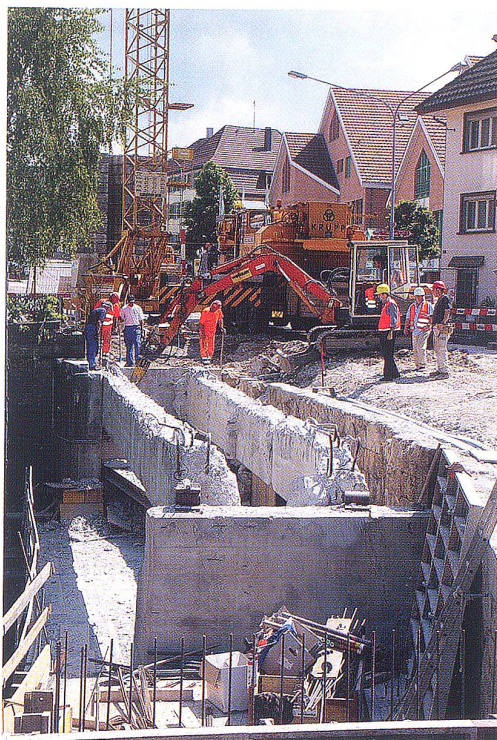
Die Alpbachbrücke in Rickenbach wird saniert.
