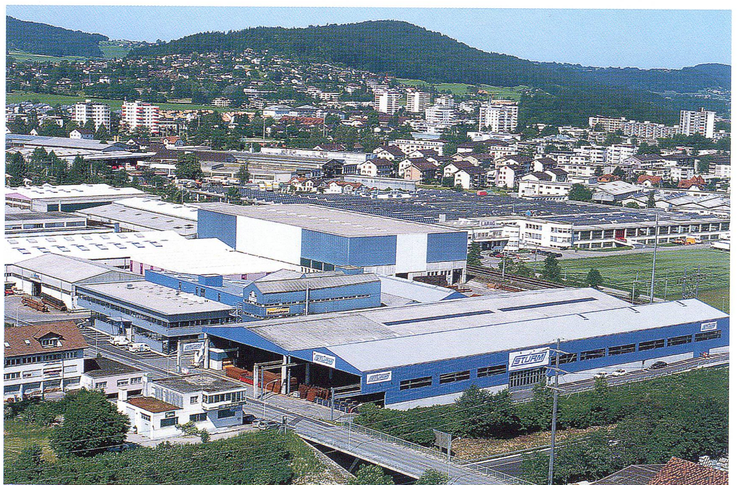
Entlang der Autobahn wurde im Baurecht der Stadt Wil – bis 2014 – eine neue Halle erstellt.
