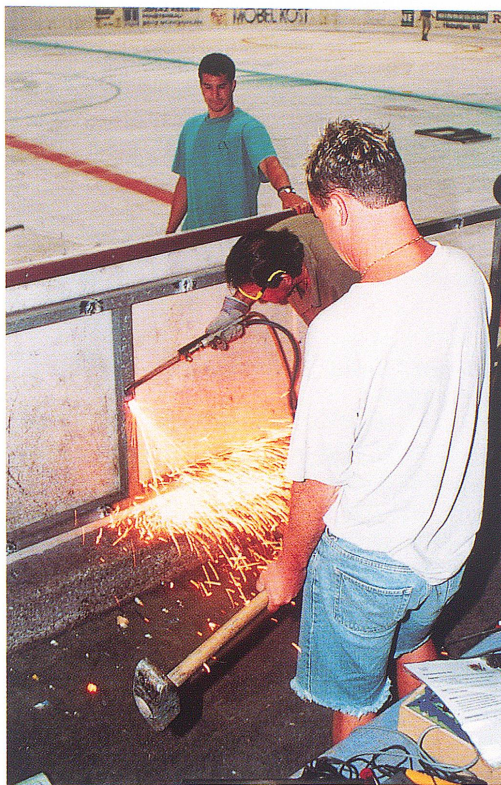
Fronarbeit beim Abbruch der alten Banden
