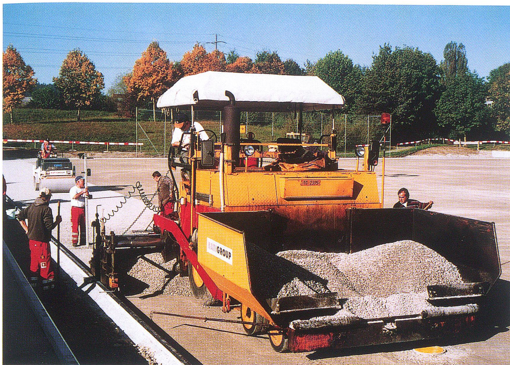
Der Split wird maschinell eingebaut
