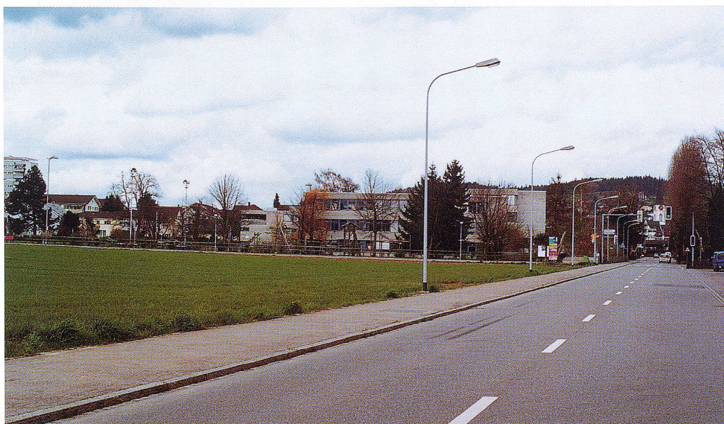
Für Zirkus und Parkplätze entsteht neuer Raum auf der Mattwiese
