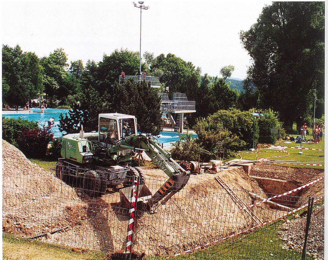
Baumaschinen beheben mitten im Sommer in der Badi Bergholz den grossen Wasserverlust.
