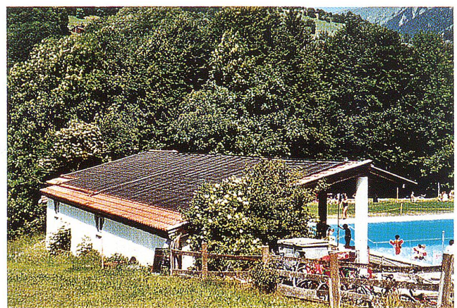
125 m 2 Solarkollektoren auf dem Kabinendach
