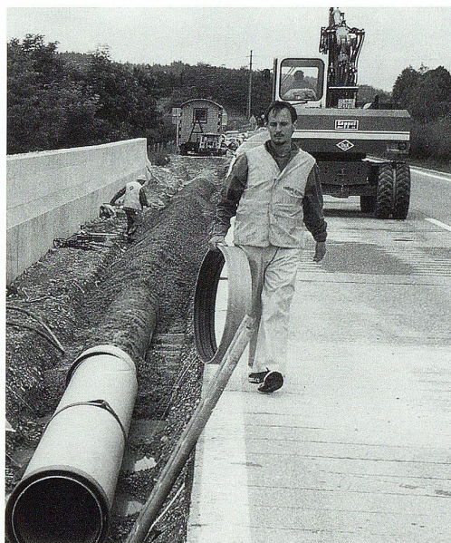
In der Schutzzone 2 wird unterhalb der New Jersey Mauer das doppelwandige Rohrsystem verlegt.
