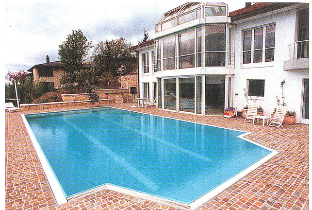
Pool mit Überfluterrinne, 8 x 14 m, Rolladenkasten am Beckenboden Bassin avec goulotte, 8 x 14 m, caisson de recouvrement à rouleau sur la plage du bassin
