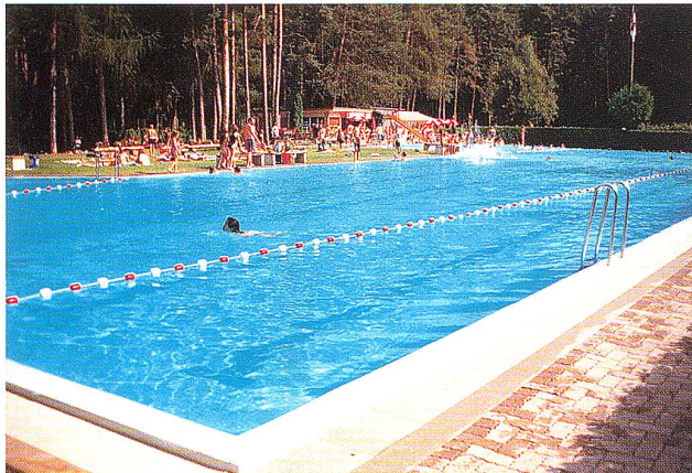
Schwimmbad Thusis (GR), Sanierung und Abdichtung mit DELIFOL-Auskleidung, 1991 Piscine de Thusis (GR): assainissement et étanchement par revêtement DELIFOL, 1991
