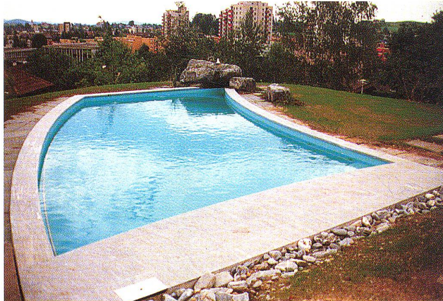
Privatschwimmbad: individuelle Formen sind kein Problem Piscine privée: les formes individualisées ne présentent aucun problème
