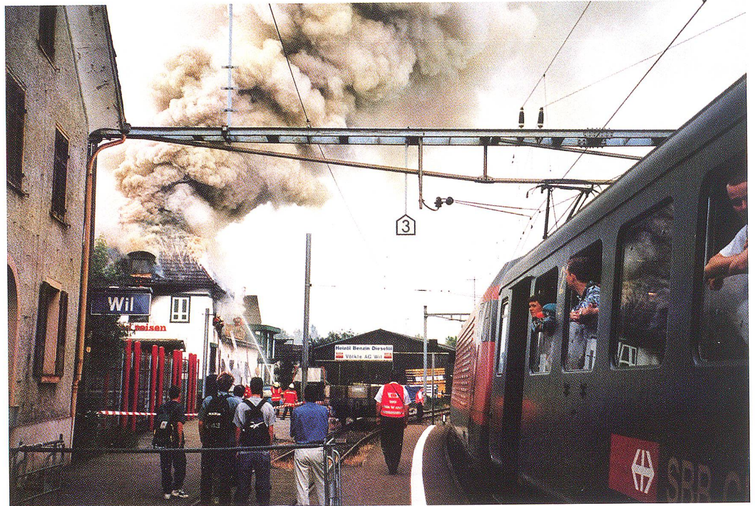
Ein Brand, gefährlich nahe am Bahngleise und am Hochspannungsstrom.
