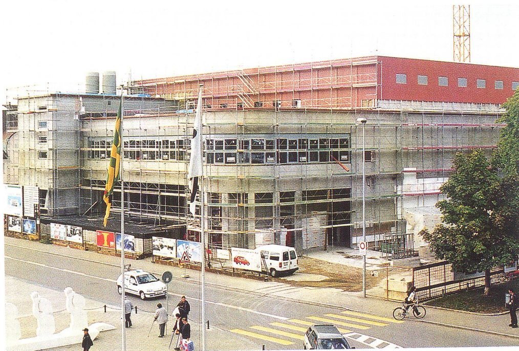
Stadtsaal Wil – Aufrichte nach nur 14 Monaten Bauzeit.
