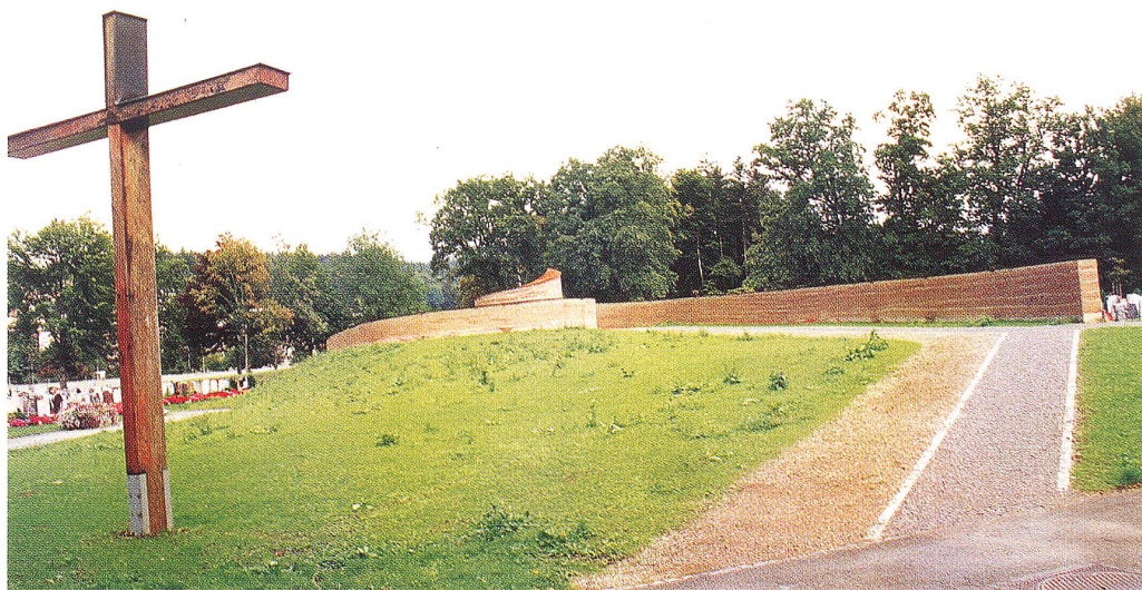
Zentrum der Friedhofanlage ist eine spiralförmige Lehmmauer. Damit wird für die neuzeitliche Feuerbestattungskultur ein würdiger Rahmen geschaffen!
