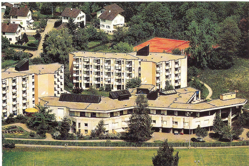
Der Sonnenhof ist heute mehr als nur ein Altersheim
