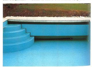
Rolladenkasten Unterflur, spezielle Ausführung Caisson de recouvrement à rouleau noyé dans le sol, exécution spéciale
