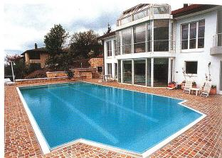
Pool mit Überfluterrinne, 8 x 14 m, Rolladenkasten am Beckenboden ssin avec goulotte, 8 x 14 m, caisson de recouvrement à rouleau sur la plage du bassir
