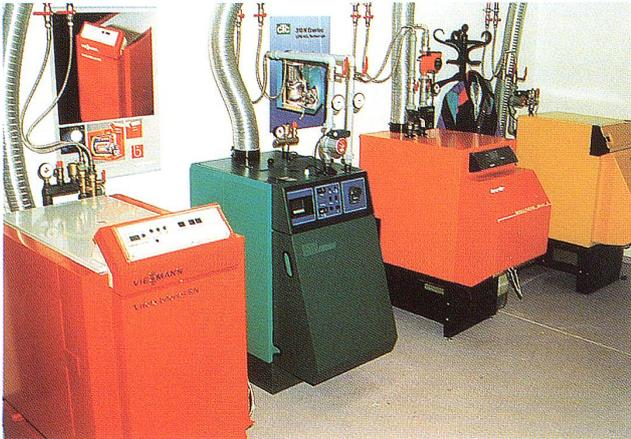
Diese Öl-Heizkessel von verschiedenen Herstellern sind angeschlossen und betriebsbereit.
