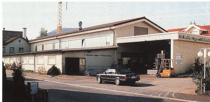
Firma Neuffer Lager-Fördertechnik an der Dorfstrasse 14 in Wilen
