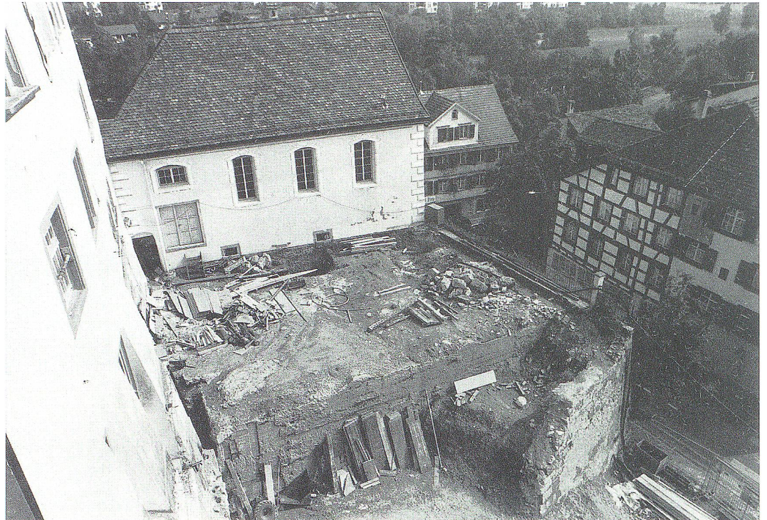
Blick auf die spätere Hofterrasse
