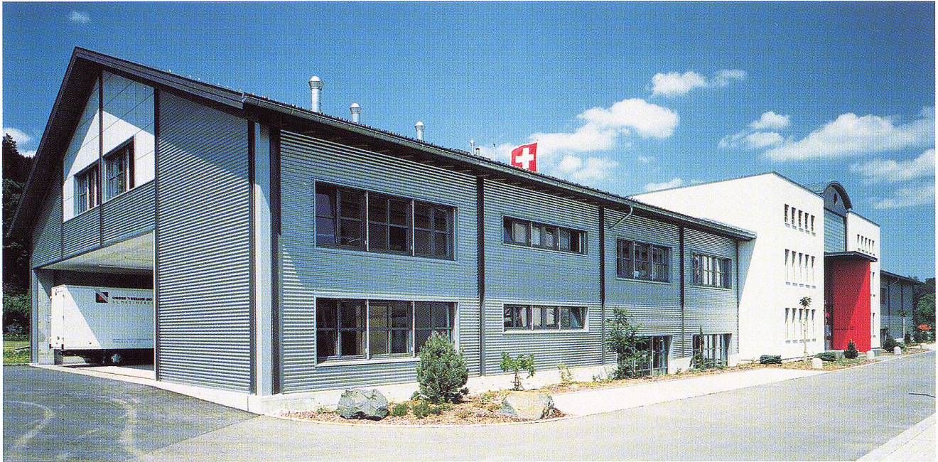
GROSS KELLER AG, eine der modernsten Schreinereien am Dorfeingang von Züberwangen.
