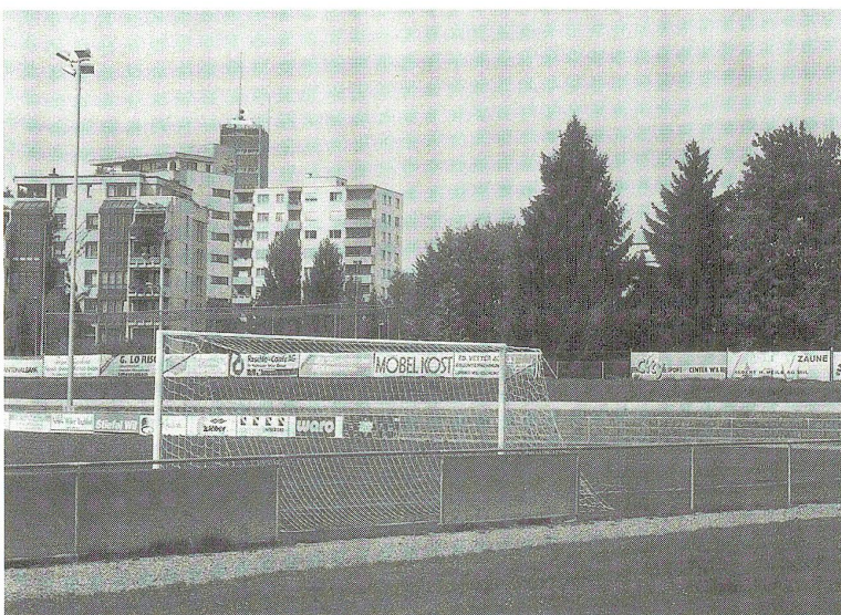
Die neue Beleuchtungsanlage leistet eine Lichtstärke von 250 Lux. Für Nati-A-Spiele müsste die Anlage auf 400 Lux ausgebaut werden, was einer Verdoppelung der geübten Kosten gleichkäme.
