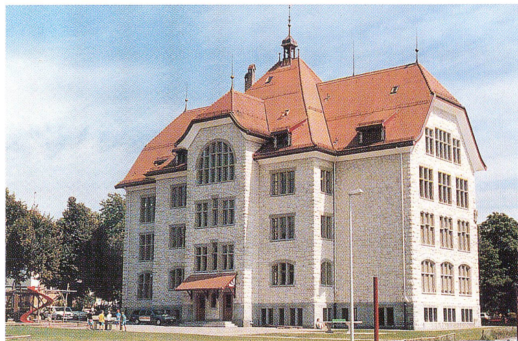
Das renovierte Alleeschulhaus in seiner ganzen Pracht.
