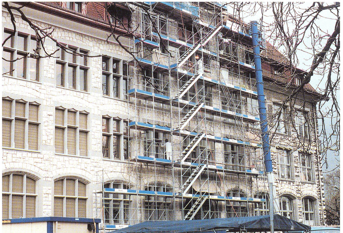
Das Alleeschulhaus in allen drei Bauphasen. Rechts bereits renoviert, in der Mitte wird renoviert und links ist noch die alte Fassade zu sehen.
