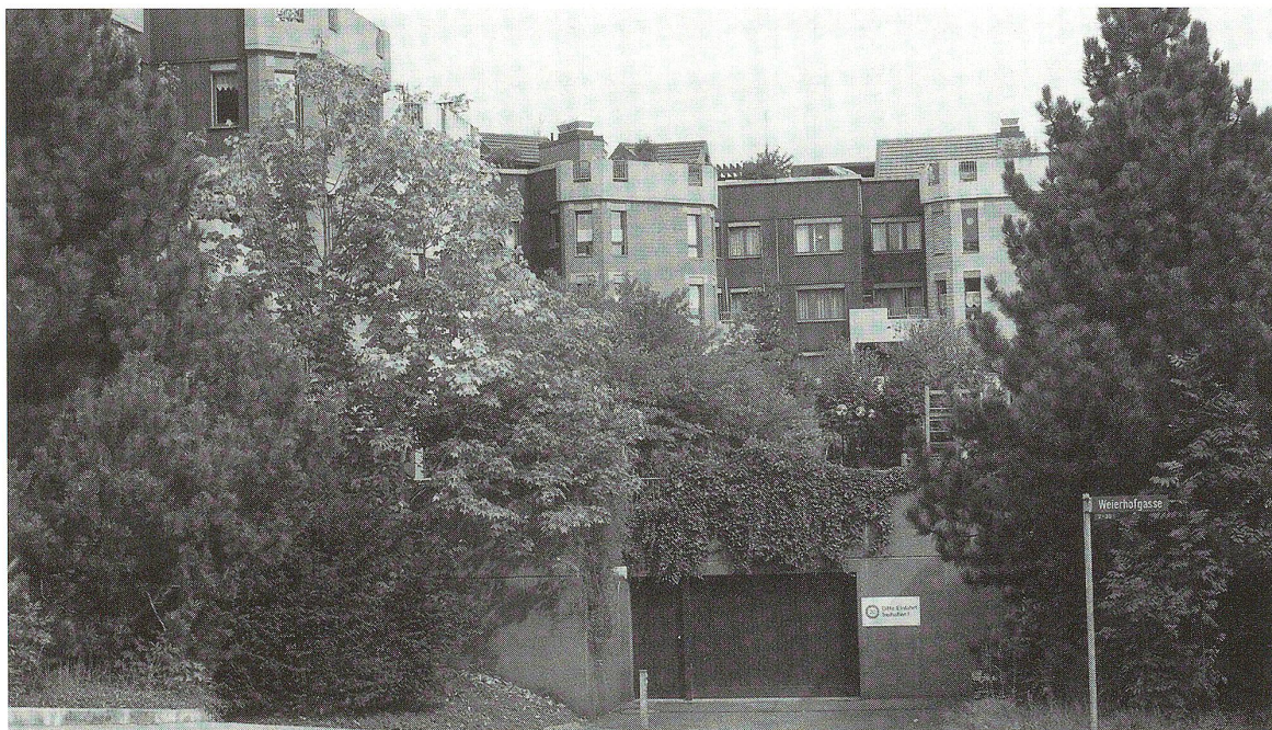
Neualtwil wie man es kennt: eine modern anmutende, vor rund zehn Jahren erstellte Wohnüberbauung. Einige dieser von institutionellen Anlegern gebauten Mehrfamilienhäuser, die langsam sanierungsbedürftig werden, wurden nun aus kaufmännischen Überlegungen heraus verkauft.
