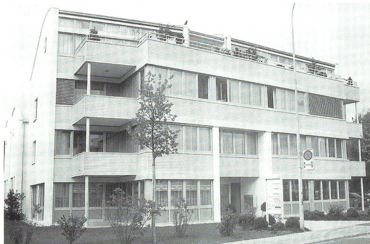
Der Zeintra-Neubau an der Hubstrasse in Wil setzt Akzente.
