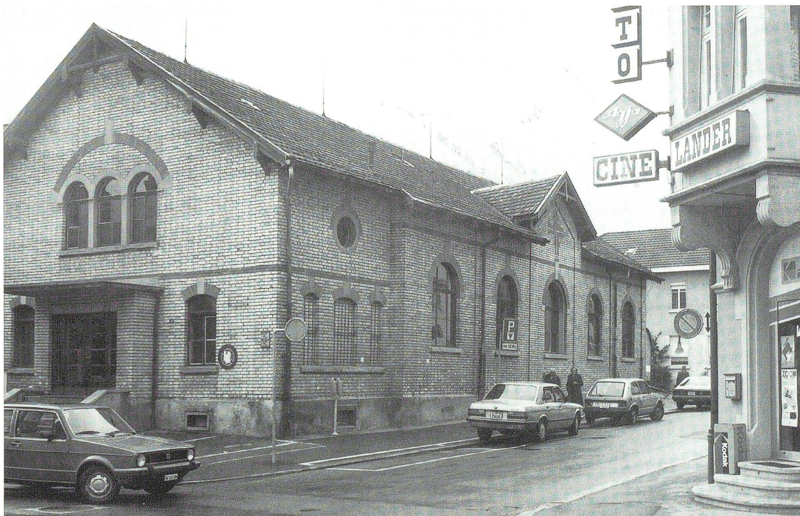
Die seit Jahren als baufällig geltende Bleicheturnhalle wurde am 22. September aus Sicherheitsgründen mit sofortiger Wirkung geschlossen.
