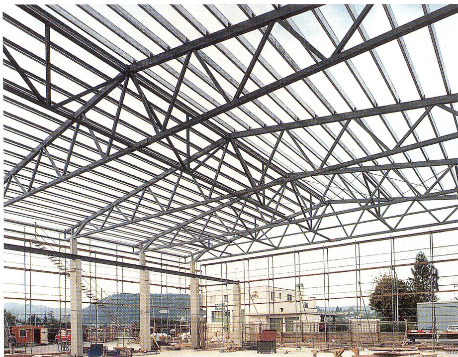
Stahlhallen-Konstruktion (Stahlbau Stiefel, Wil)
