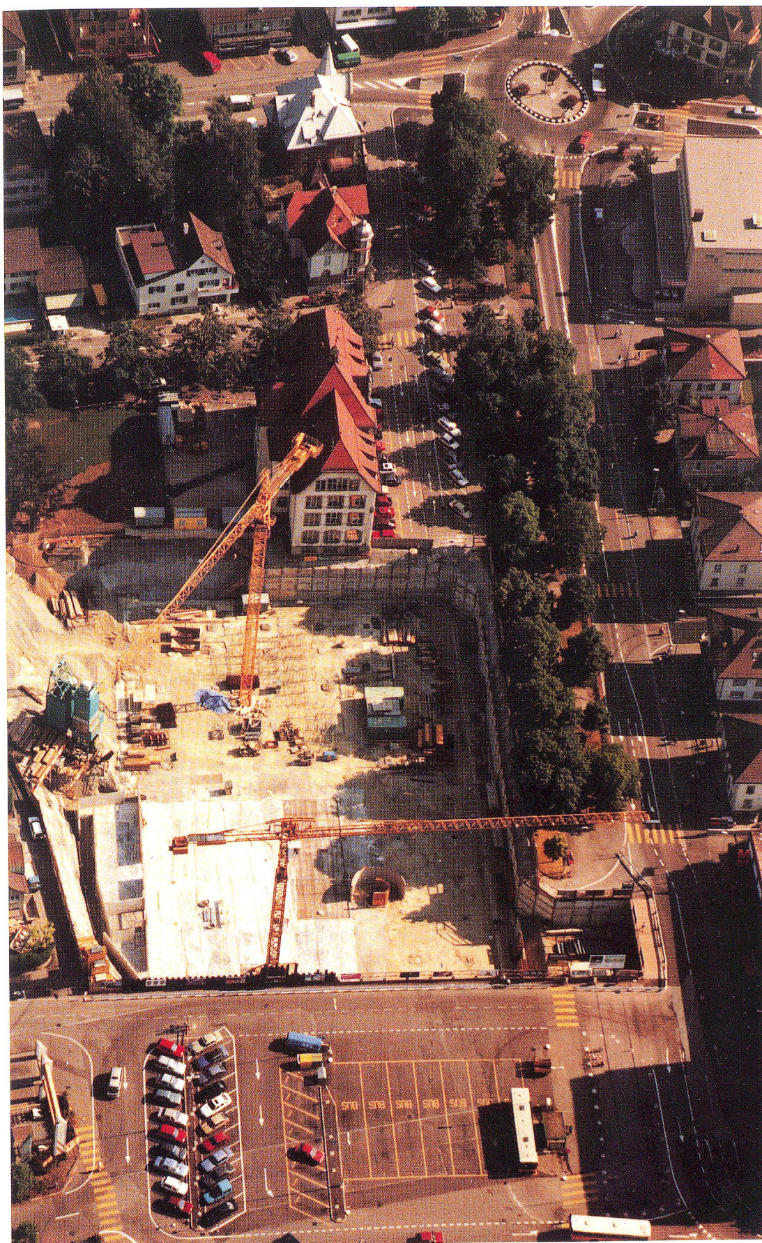
Stand der Bauarbeiten am 26. Juli 1990.
