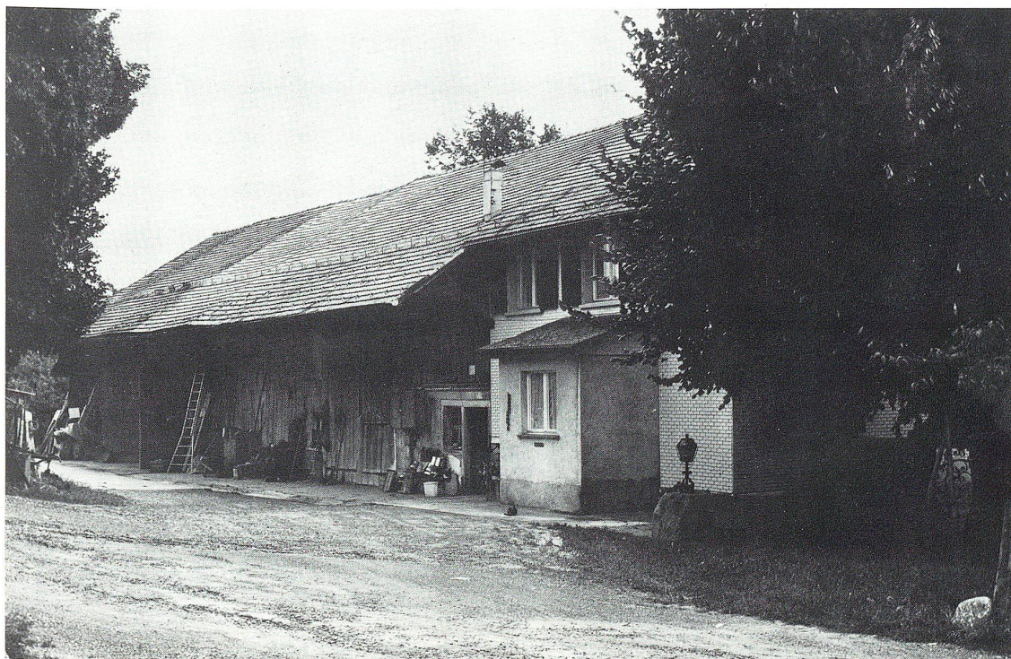
Wo früher der Hof von Adolf Hollenstein zu finden war, erheben sich heute die modernen Blockbauten an der St. Gallerstrasse. (Unten) Der Hof von Guido Flammer auf Neugruben steht am Rande der Neubauesiedlung. . .
