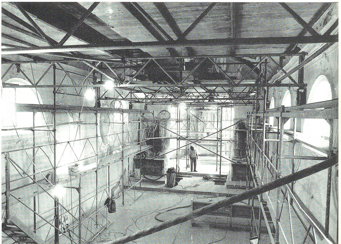
Die Wallfahrtskirche Dreibrunnen während der Renovationsarbeiten.
