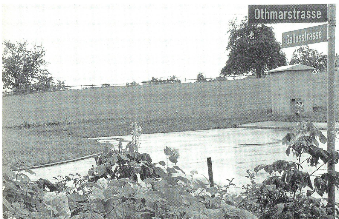
Der neue Radweg entlang des Altersheims «Sonnenhof».
