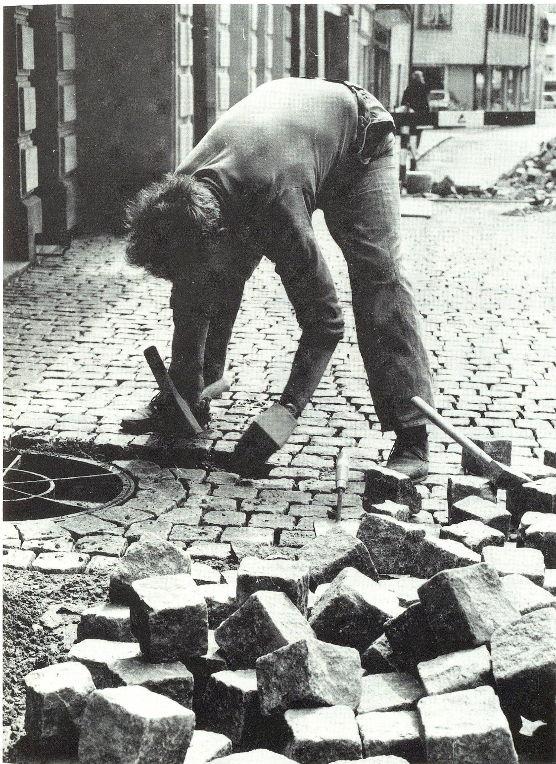
Fast wie in alten Zeiten – Pflasterer bei der Arbeit.
