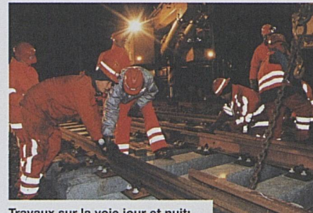
Travaux sur la voie jour et nuit: l'entretien – par branches d'activité
