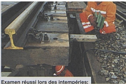
Examen réussi lors des intempéries: rehaussement d'un pont en Valais
