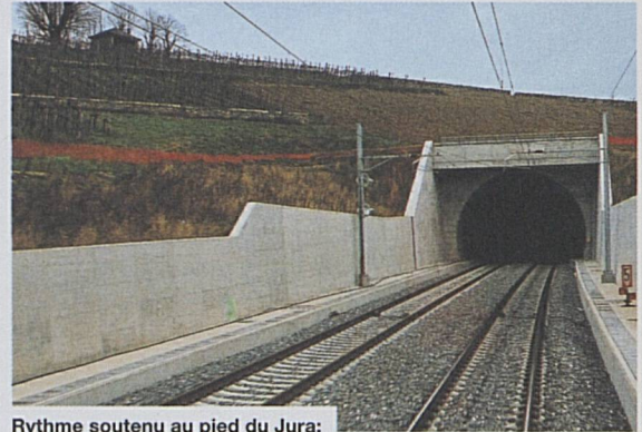
Rythme soutenu au pied du Jura: tunnel Rail 2000 près de Gorgier NE
