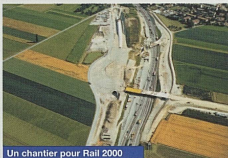
Un chantier pour Rail 2000
