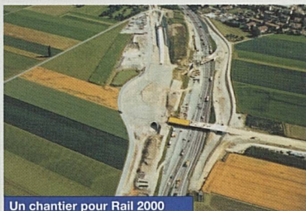
Un chantier pour Rail 2000
