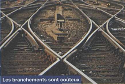
Les branchements sont coûteux à l'achat et à l'entretien.
