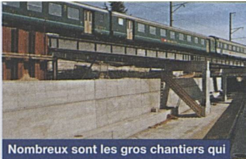
Nombreux sont les gros chantiers qui préparent le chemin de fer de demain.
