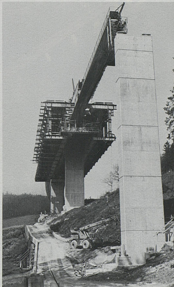
Portique de coffrage avec flèche de lancement
