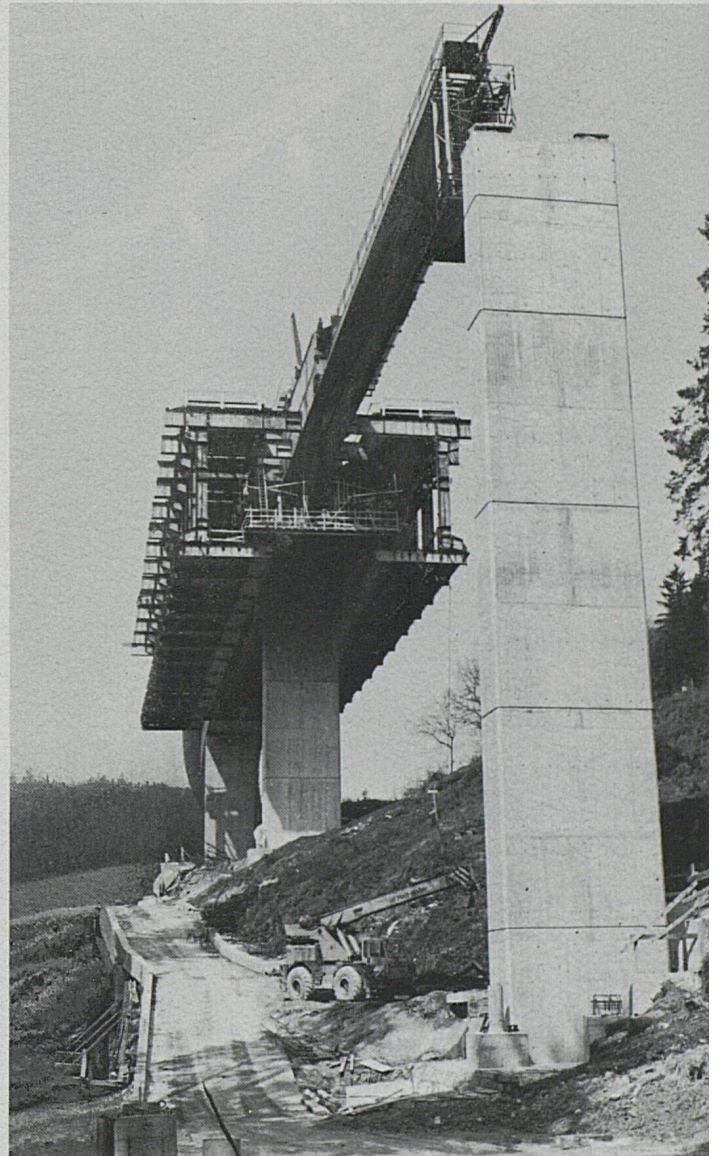
Portique de coffrage avec flèche de lancement
