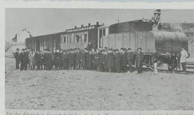
Zug des elektrischen Versuchsbetriebes «Seebach - Wettingen» mit der zunächst als Umformerlokomotive gebauten Lokomotive Nr. 1 anläßlich einer Vorführung am 12. März 1904
