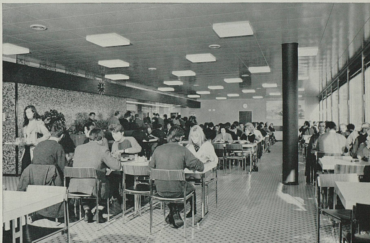
Cantine du personnel inaugurée en novembre 1968 à la gare de marchandises de Genève-La Praille.
