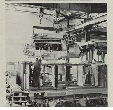
Le moteur diesel d'une locomotive Em 3/3 et son générateur principal s installé sur le cadre de montage et préparés en vue de l'essai. A gaud le générateur d'excitation et le générateur auxiliaire sont sur un a cadre. Les radiateurs d'eau et d'huile se trouvent au sous-sol.
