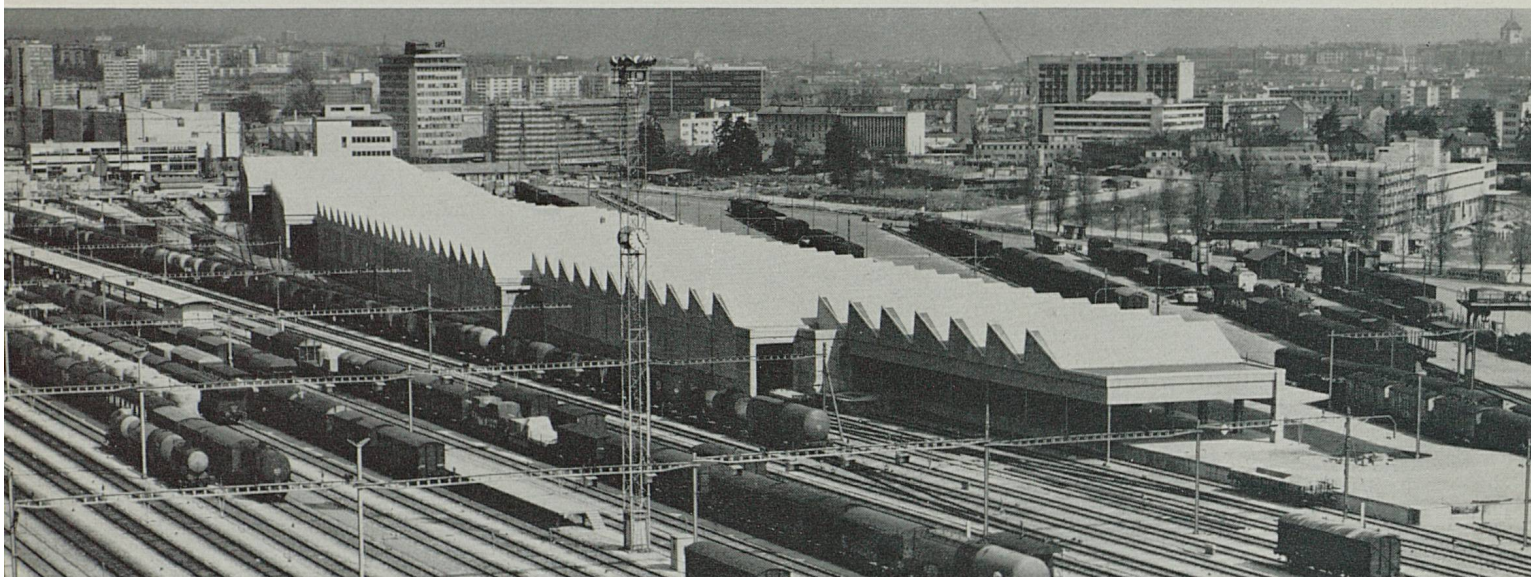
Gare aux marchandises et de triage de Genève La Prairie: les nouvelles halles avec toiture en sheds
