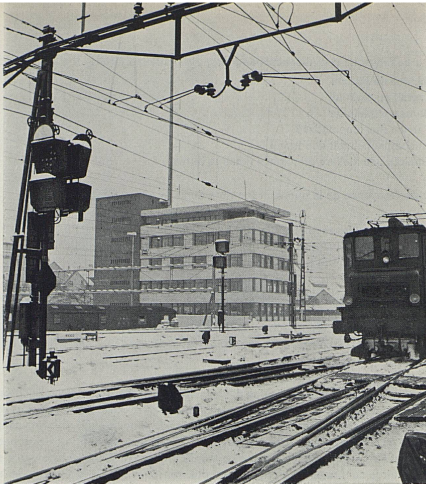
Nouveau bâtiment à la gare principale de Zurich. Cet édifice abrite notamment les bureaux de la régulation des trains et des locomotives, chargés de surveiller le trafic sur les lignes principales du III e arrondissement.
