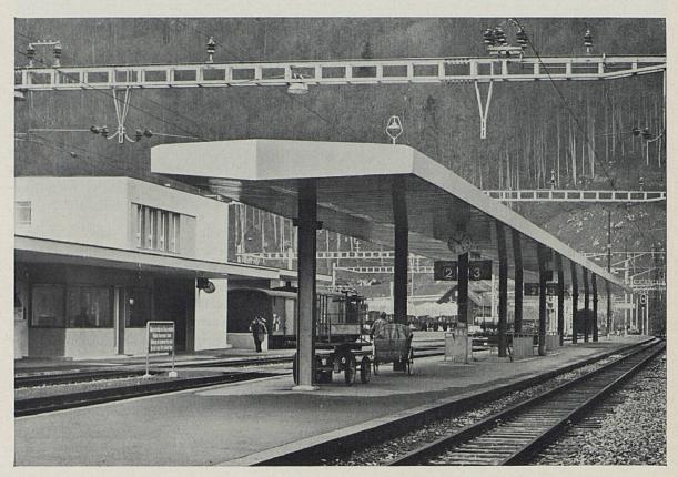
Le raccordement de l'ancien chemin de fer Stansstad-Engelberg à la ligne CFF du Brunig a nécessité l'agrandissement et la modernisation de la gare de Hergiswil. Le nouveau quai intermédiaire a une longueur de 210 mètres; avec sa marquise recouverte en duralumin, il assure la protection des voyageurs.
