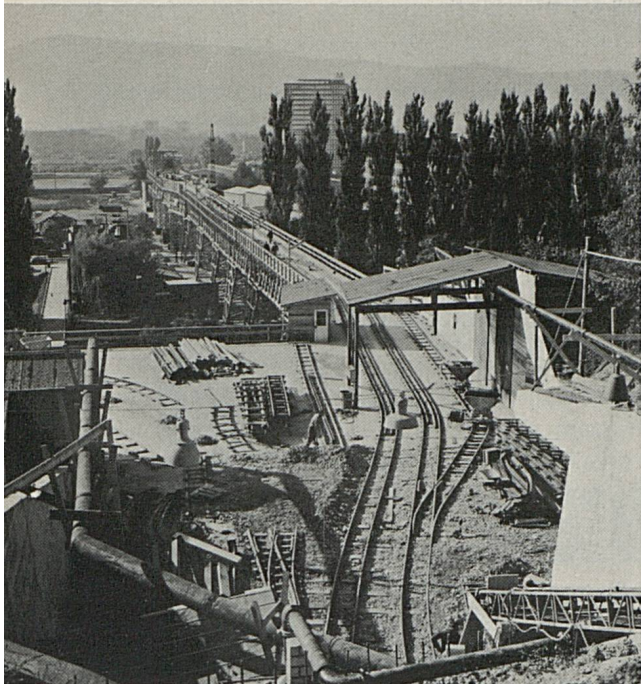
La nouvelle ligne Zurich Altstetten-Zurich Oerlikon nécessite le percement d'un tunnel de 2118 m à travers le Käferberg. A gauche, les installations de chantier du portail sud; à droite, l'excavation de la calotte, au-dessus de la galerie de base, au travers de la moraine.
