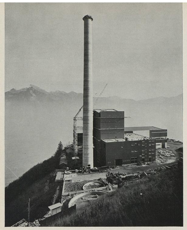
Les CFF sont intéressés à la Centrale thermique de Vouvry S. A.; le premier groupe de 150 000 kW qu'elle construit pourra fonctionner probablement dès l'automne 1965. A droite de la cheminée, haute de 120 mètres, la chaufferie, puis la salle de commande et, en retrait, la salle des machines.
