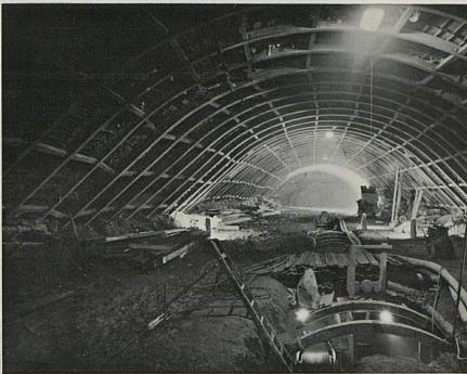
La nouvelle ligne Zurich Altstetten–Zurich Oerlikon nécessite le percement d'un tunnel de 2118 m à travers le Käferberg. A gauche, les installations de chantier du portail sud; à droite, l'excavation de la calotte, au-dessus de la galerie de base, au travers de la moraine.
