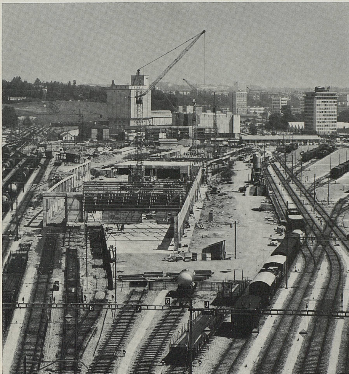
A la nouvelle gare aux marchandises de Genève-La Praille, toutes les voies sont posées. On construit actuellement les halles pour le trafic de détail.
