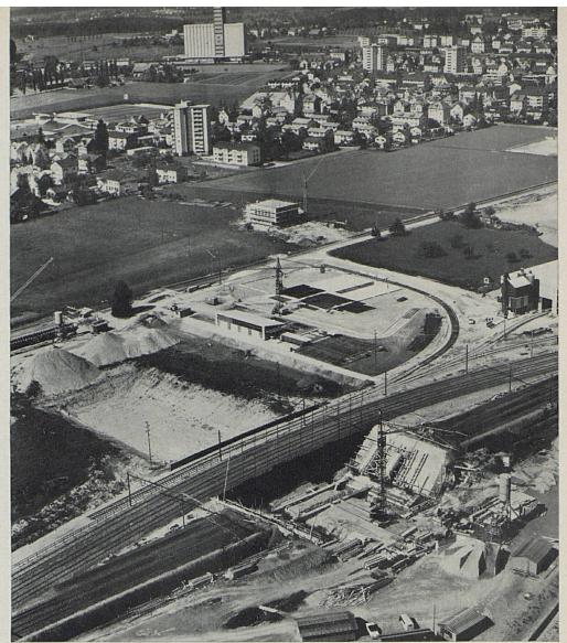
Construction d'un passage inférieur pour la route nationale N1 près de Wil (SG). Pour entraver le moins possible le trafic ferroviaire lors de l'établissement d'ouvrages de croisement, comme aussi pour en faciliter la construction, on procède au ripage provisoire des voies dans la mesure où les conditions topographiques et l'absence de bâtiments le permettent.
