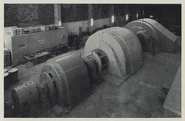
Les nouveaux groupes convertisseurs des Chemins de fer fédéraux permettent des échanges de puissance et d'énergie électrique avec le réseau d'intérêt général. La photographie montre l'imposante installation de Rupperswil.
