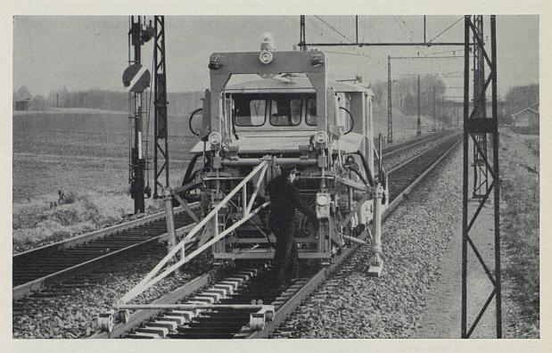
Pour la pose et l'entretien de la voie, nous utilisons de plus en plus des engins modernes de conception suisse. Cette bourreuse-niveleuse automatique soulève la voie à la hauteur désirée et corrige au besoin la différence de niveau entre les deux files de rails; en l'espace d'une heure, elle est capable de bourrer les traverses sur 200 m de voie
