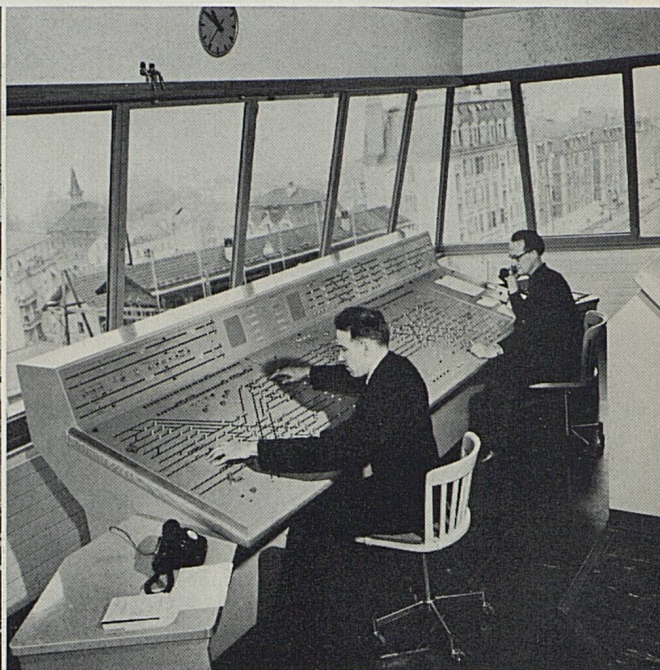
A la gare de Lausanne, un poste d'enclenchement moderne à touches d'itinéraires, du type géographique, est entré en service le 1 er décembre.
