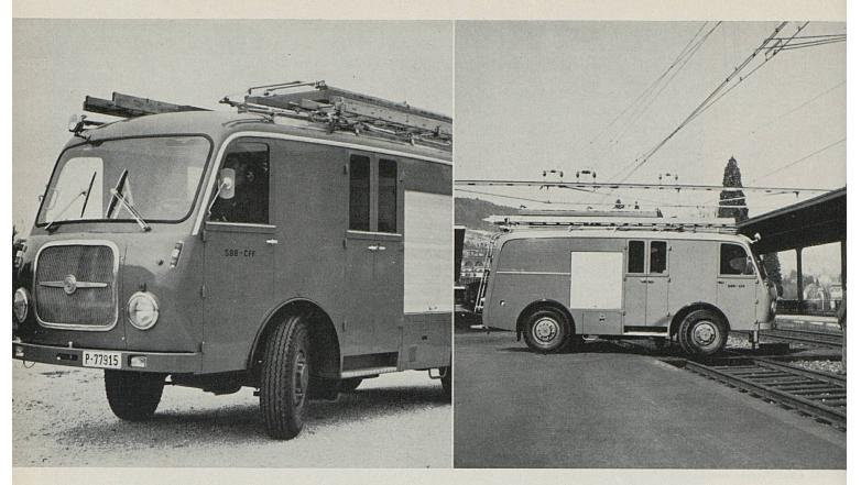
Prototype de fourgon de montage rail-route pour l'entretien des lignes de contact. Il n'est pas prévu de généraliser l'emploi de ce Fourgon de montage en ordre de marche
