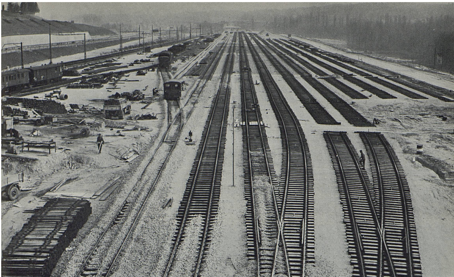
Le faisceau de réception du nouveau triage de Lausanne, dans la région de Denges-Lonay, est presque achevé. Pendant l'Exposition nationale de 1964, ces voies serviront à garer les nombreuses compositions de trains spéciaux
