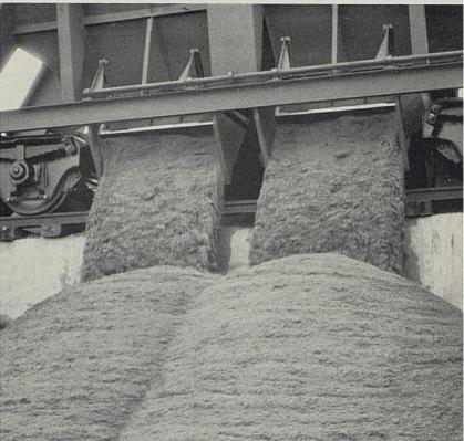
wagons spéciaux à déchargement par gravité amènent le gravier et le sable jusqu'aux chantiers der autoroutes.
