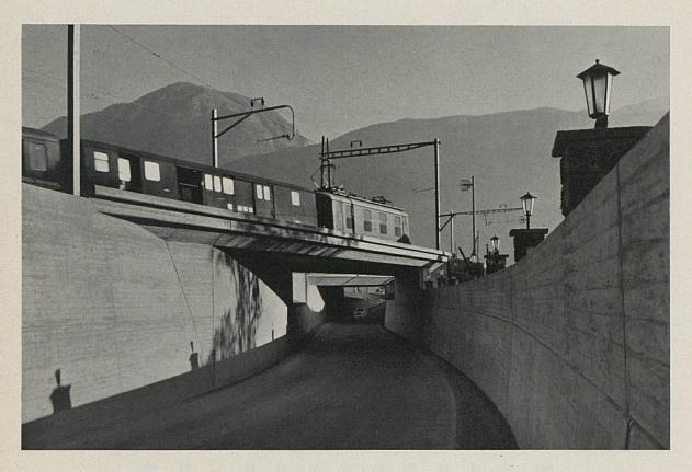
Passage inférieur pour la route du Saint-Gothard, à Melide. Jusqu'à l'achèvement de la digue, le pont destiné à la future route d'accès à cette localité est utilisé pour la voie ferrée. La construction de ce passage inférieur, qui assurera plus tard la liaison avec la route nationale, a permis de supprimer également le deuxième passage à niveau à proximité de la digue de Melide.
