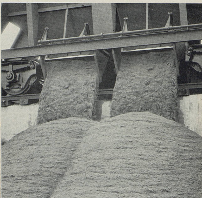
Les wagons spéciaux à déchargement par gravité amènent le gravier et le sable jusqu'aux chantiers des autoroutes.
