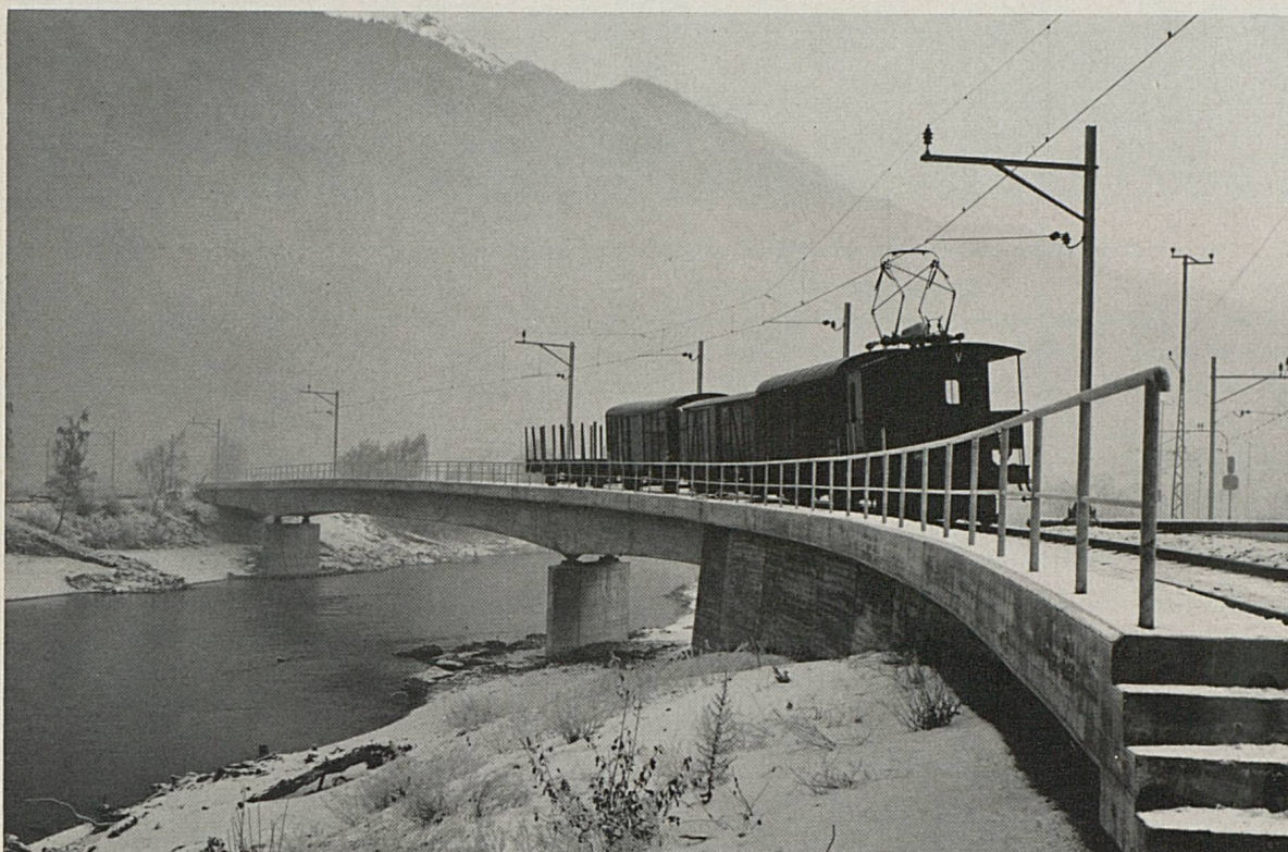
Le nouveau pont en béton précontraint sur le Rhône, non loin de la station de Gampel-Steg.
