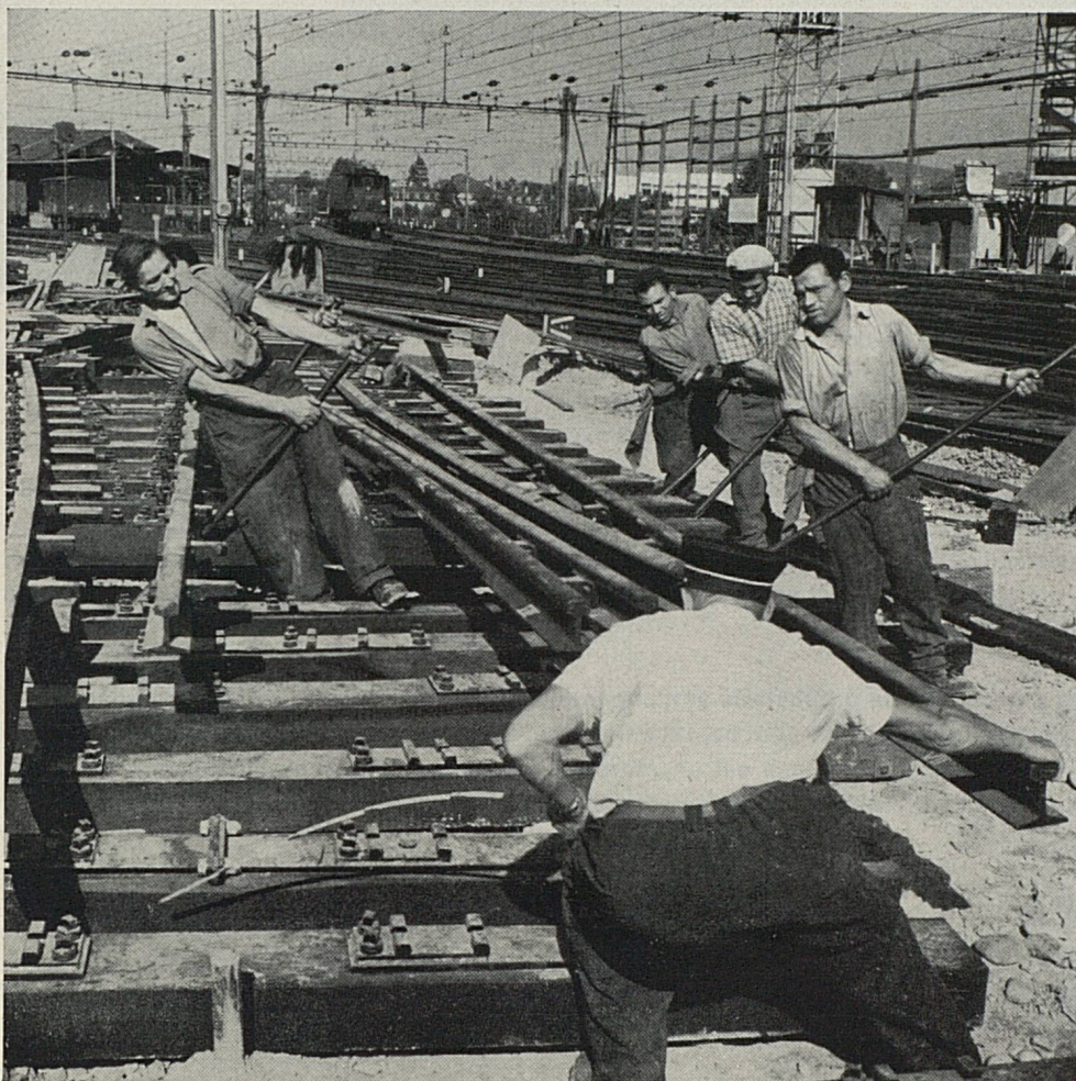
Même la pose des branchements est inséparable de l'effort humain
