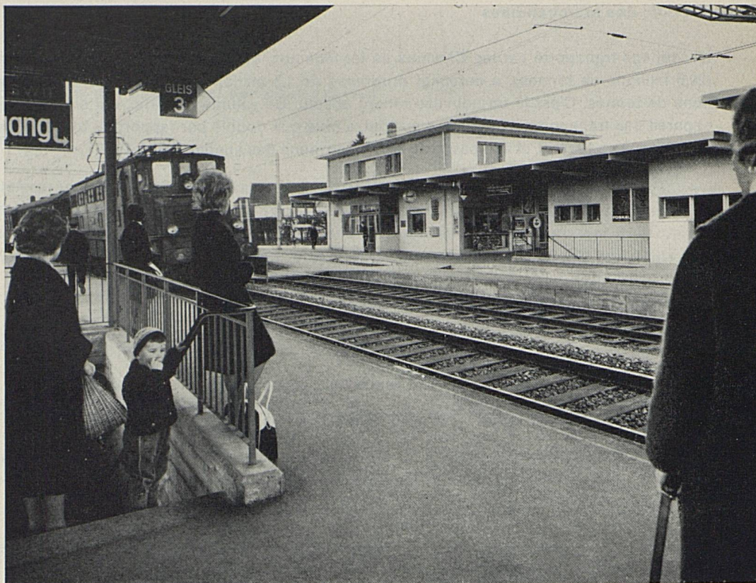
Le nouveau bâtiment de gare de Busswil
