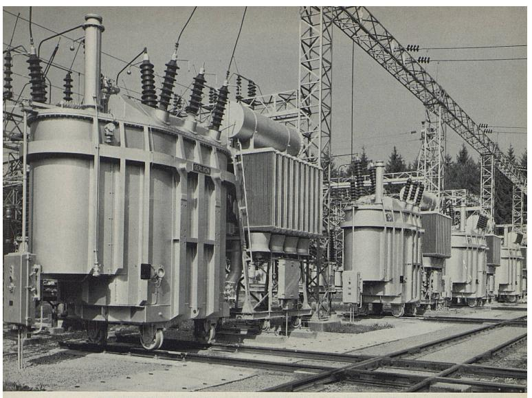
Pour améliorer le couplage entre le réseau primaire à 132 kV et le réseau de distribution à 66 kV, les anciens transformateurs de la sous-station de Rupperswil, d'une puissance totale de 36 MVA, ont été remplacés par les quatre nouvelles unités de réglage 138-114/66 kV, totalisant 100 MVA, visibles sur notre photo.
