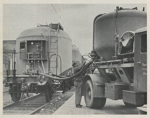
Le ciment et d'autres marchandises pulvérulentes en vrac sont aujourd'hui principalement transportés au moyen de wagons-silos. Des installations pneumatiques permettent un transbordement aisé, rapide et économique
