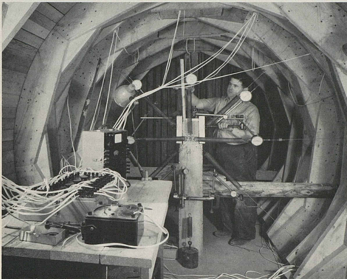
Mesure des contraintes dans le tunnel à câbles de la nouvelle installation d'enclenchement de Zurich
