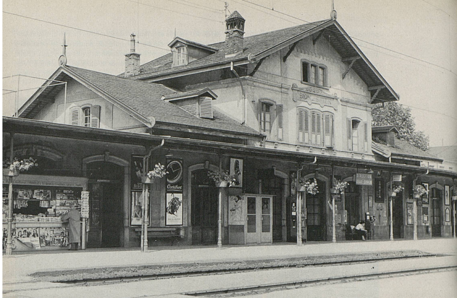
Le bâtiment de gare de Sion construit en 1873 ...
