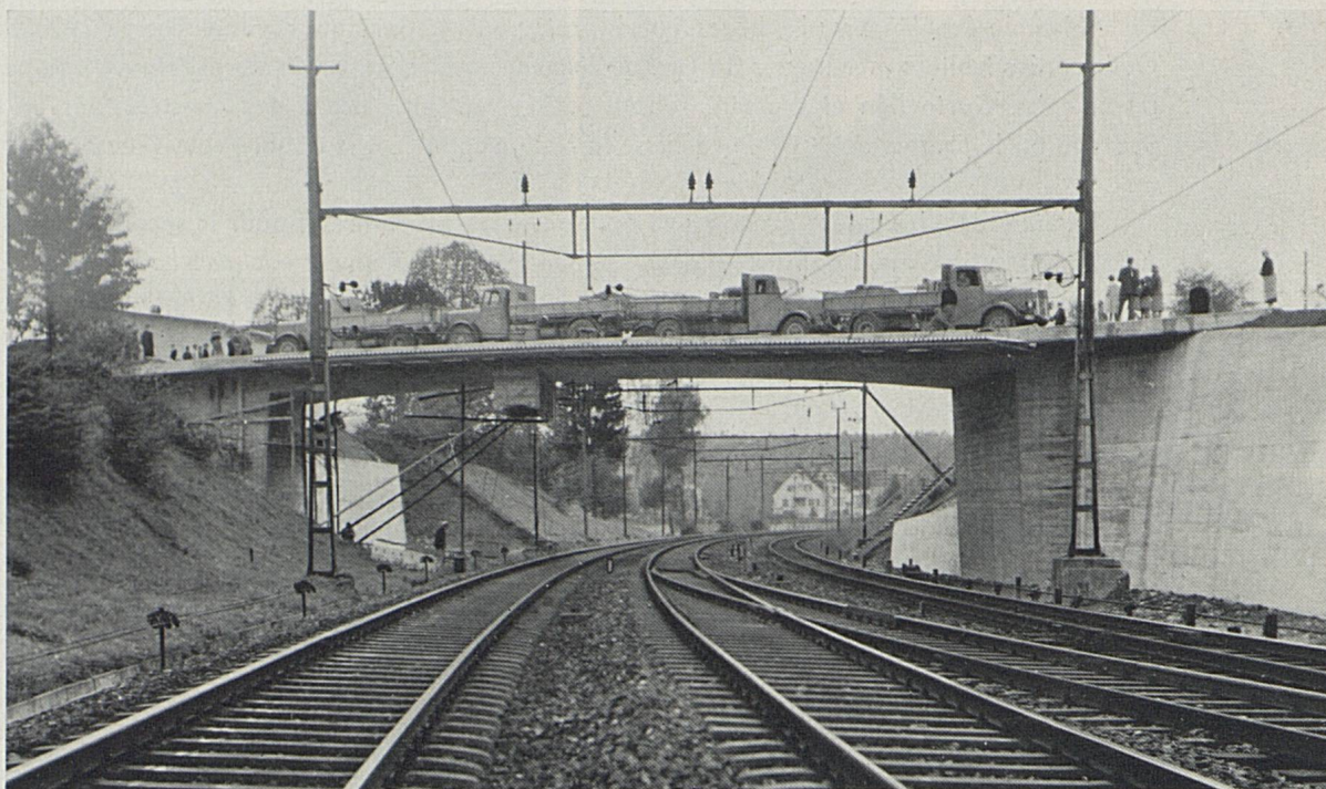
Effretikon: Le nouveau passage supérieur routier «Sud» est soumis aux essais de charge
