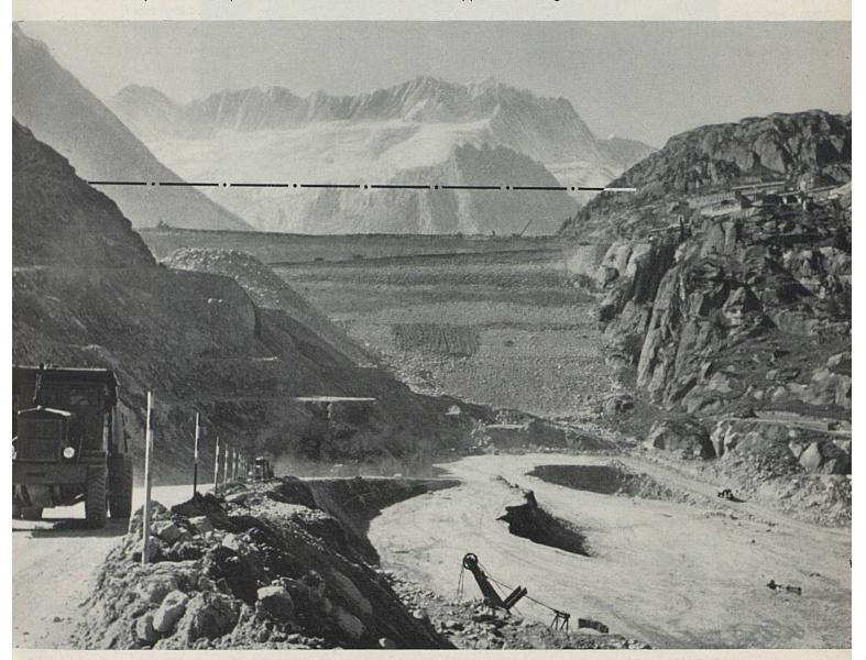
Digue de la grande centrale de Göschenen. Vue de la colline de matériaux, du côté du parement aval. A droite, en haut, les baraquements.
